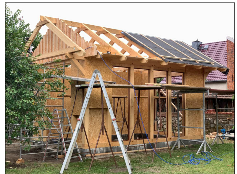
Pavillon, hier noch im Bau
